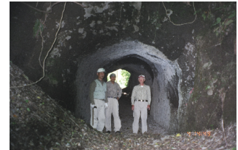
山屋トンネル 凝灰岩を掘り抜いた素堀で「日向往還の山屋トンネル」 という。開通年代不明。長さ22m、高さ3.3m 出口に地藏尊（明治3年）あり
